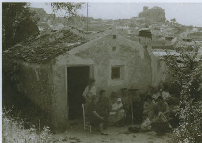
Tipología constructiva de Sta. Cruz de la Zarza en los años 60. Fotógrafo: J. Cesáreo Sánchez-Mata.
