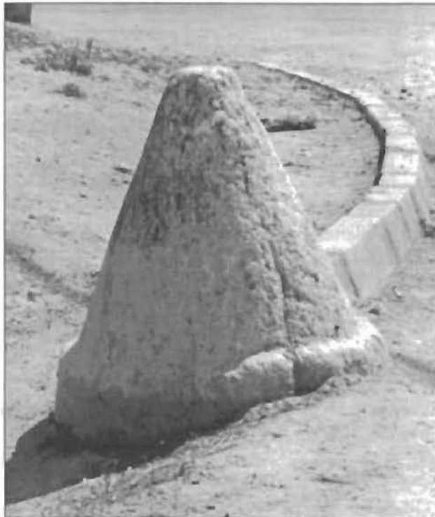
Pilones de piedra caliza (postes) que cerraban el paso a los carruajes para no hundir la bóveda del encaño. Calle Zanja
