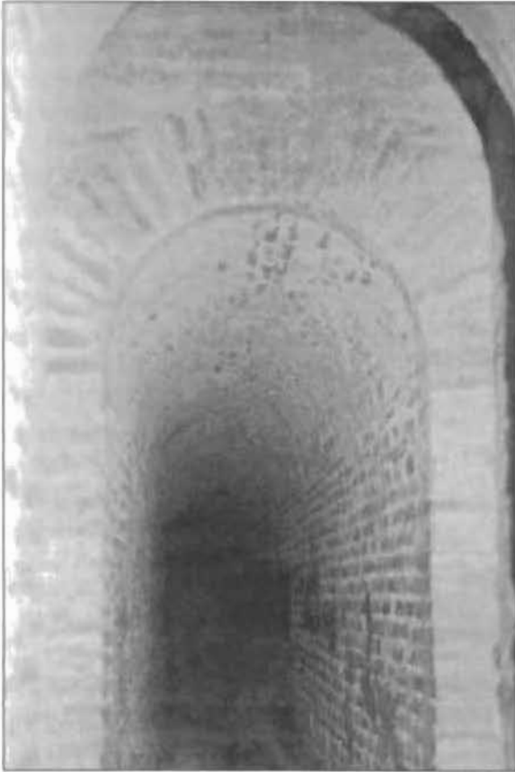
Arcos de ladrillo de la galería principal o mina del encaño.
