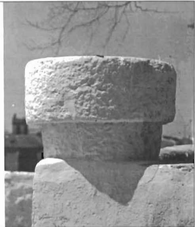
Pilones de piedra caliza (postes) que cerraban el paso a los carruajes para no hundir la bóveda del encaño. Calle Zanja
